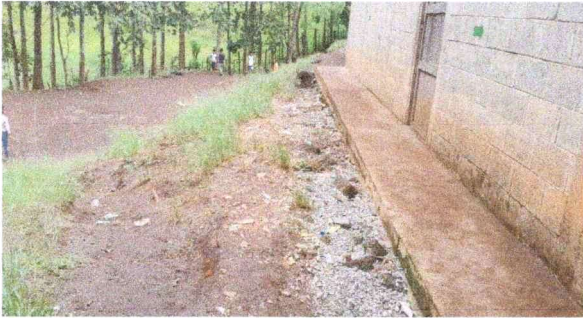
Foto 3: Imagen lateral de establecimiento en donde se puede ver la necesidad de pintura en muros exteriores.
