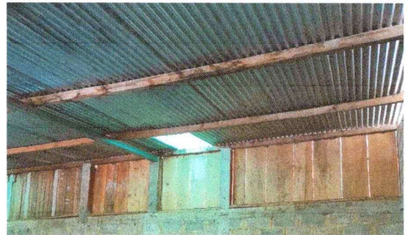
Foto 6: Vista de estructura de techo de aula con necesidad de ser cambiado para brindar mejores condiciones de estudio a los niños.
